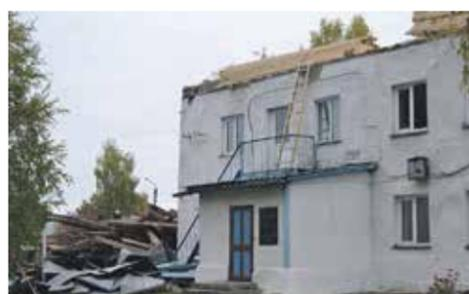
На участке демонтированной части крыши уже монтируют скатную конструкцию из бруса. После деревянный каркас покроют листами профнастила. Затем все действия повторят на второй половине крыши.
